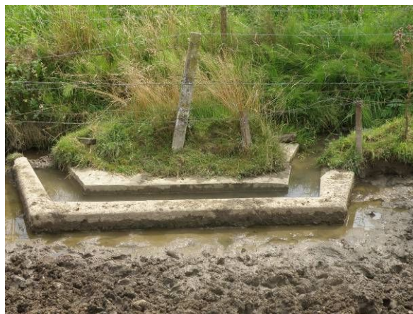
Aménagement simple et efficace d'un abreuvoir empêchant l'accès direct à un cours d'eau (ici sur un petit affluent du ruisseau d'En Dessous à Silenrieux).
